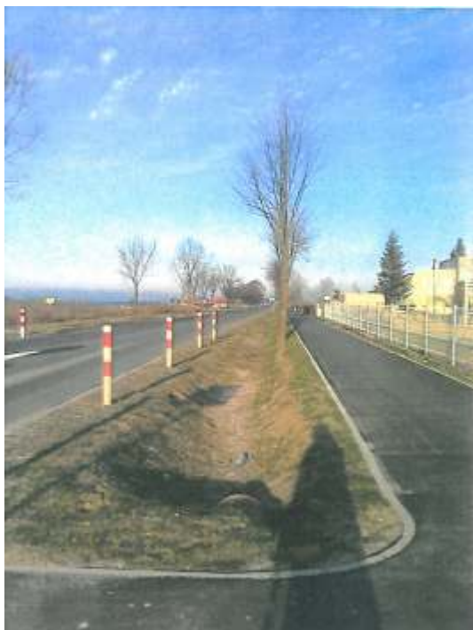
Droga powiatowa 1322G ul. Syrokomli w Lęborku
