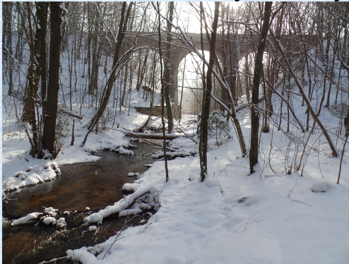
Wiadukt kolejowy w Karczemkach zimą.
