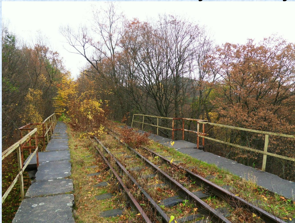
Wiadukt kolejowy w Karczemkach jesienią.
