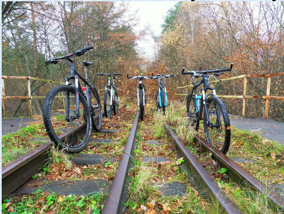
Wiadukt kolejowy w Karczemkach jesienią.
