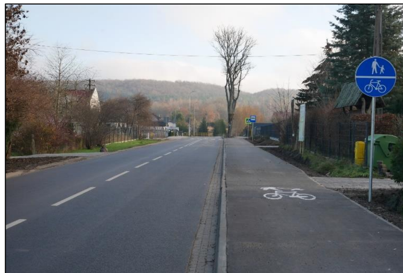
Przebudowa drogi powiatowej NWL, ul. Młynarska
