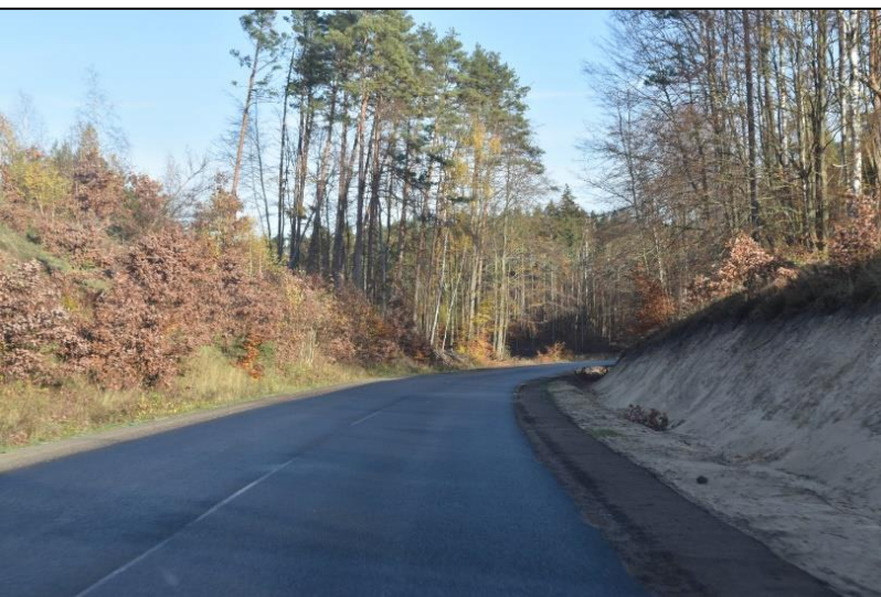
Przebudowa drogi powiatowej Pogorzelice – Unieszyno
