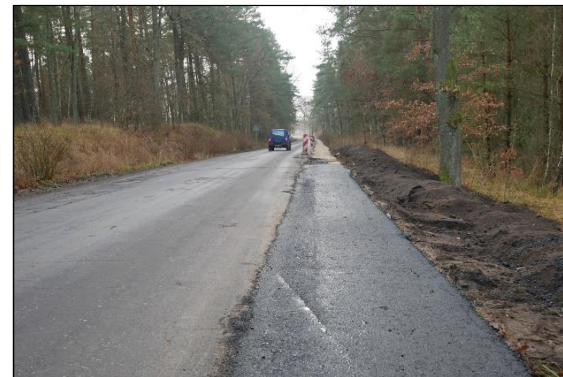
Przebudowa drogi powiatowej odc. Łebień - Garczegorze
