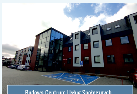
Budowa Centrum Usług Społecznych w Łęborku
