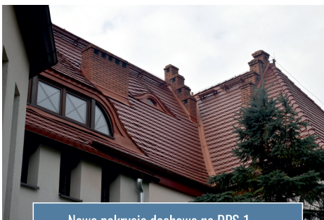
Nowe pokrycie dachowe na DPS 1
