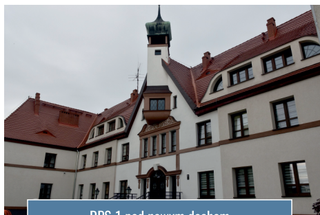
DPS 1 pod nowym dachem
