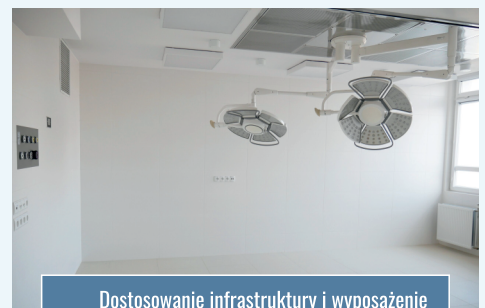
Dostosowanie infrastruktury i wyposażenie oddziału Położniczo-Ginekologicznego
