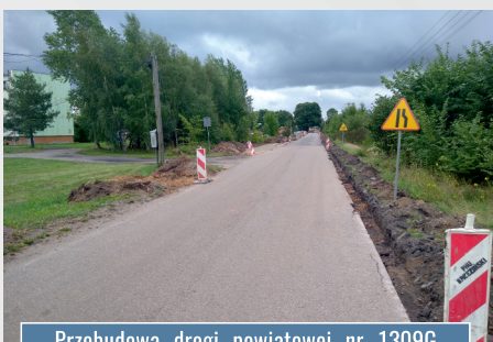
Przebudowa drogi powiatowej nr 1309G na odcinku od m. Kopaniewo do skrzyżowania z DP 1312G w m. Łebień
