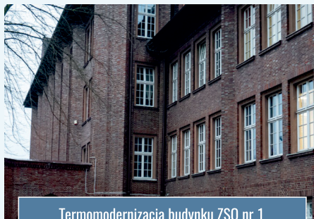
Termomodernizacja budynku ZSO nr 1 w Łęborku
